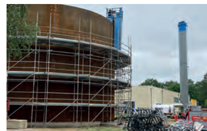
Wärmespeicher im Bau (li. Innenansicht, re. Aussenansicht mit Heizwerk Nord II im Hintergrund)
