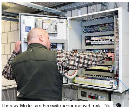
Thomas Müller am Fernwärmepumpenschrank. Die gesamte Steuerungs- und Regeltechnik ist neu.
