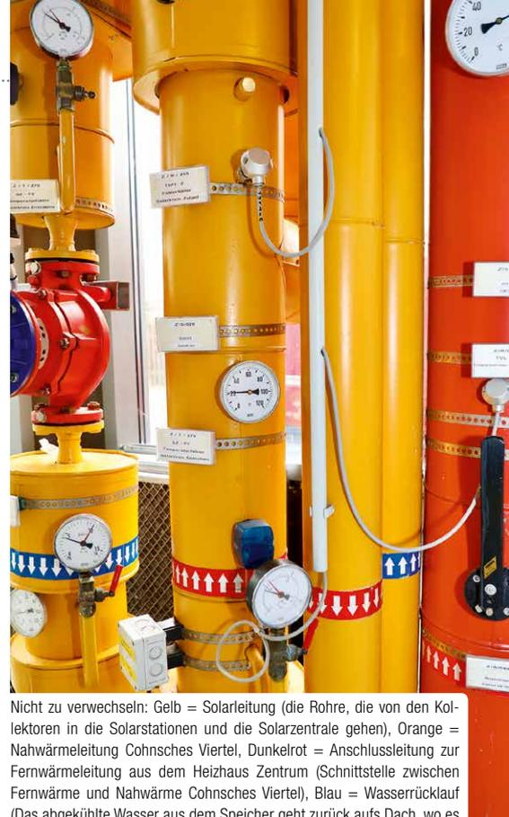
Nicht zu verwechseln: Gelb = Solarleitung (die Rohre, die von den Kollektoren in die Solarstationen und die Solarzentrale gehen), Orange = Nahwärmeleitung Cohnsches Viertel, Dunkelrot = Anschlussleitung zur Fernwärmeleitung aus dem Heizhaus Zentrum (Schnittstelle zwischen Fernwärme und Nahwärme Cohnsches Viertel), Blau = Wasserrücklauf (Das abgekühlte Wasser aus dem Speicher geht zurück aufs Dach, wo es von der Sonne wieder erwärmt wird)
