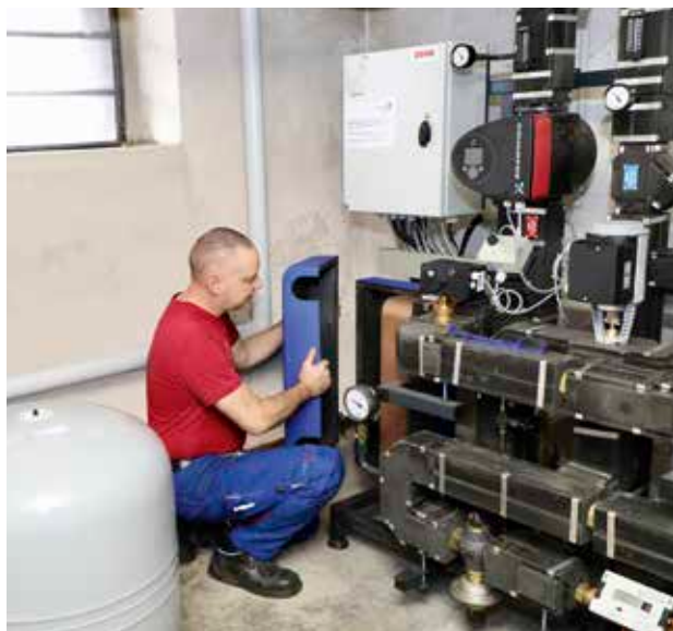
Stadtwerke-Kundendienstmonteur Karsten Herrmann beim Check einer Fernwärme-HA- Station in einem Hennigsdorfer Mehrfamilienhaus
