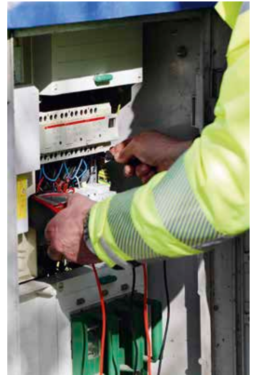
Von über 50 Schaltkästchen führen die Kabel zu 3.700 städtischen Lichtpunkten
